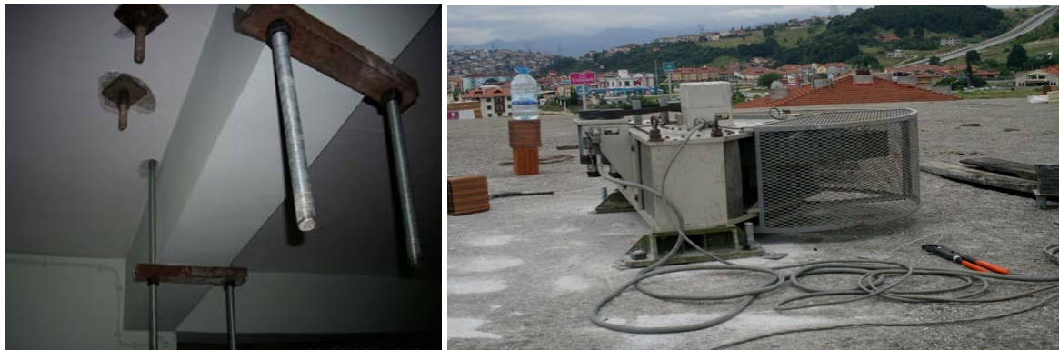
Şekil 3 Yapay deprem üreticinin çalışılan bina çatı döşemesinde kütle merkezinden geçen uygun yapı elemanına montajının alttan görüntüsü solda, üstten çalışırkenki görüntüsü, sağda.
