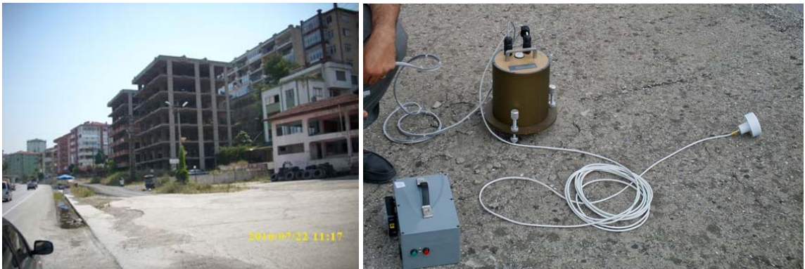
Şekil 2 Çevrel titreşim ölçümlerinin ve dinamik zorlama testlerinin yapıldığı Karamürsel girişi Halidere mevkinde bulunan bloklar, solda. Bir gözlem noktasında üç bileşen ivme ölçer, enerji besleme ünitesi, RF-modem modülü ve GPS-anten'den oluşan düzenek, sağda.
